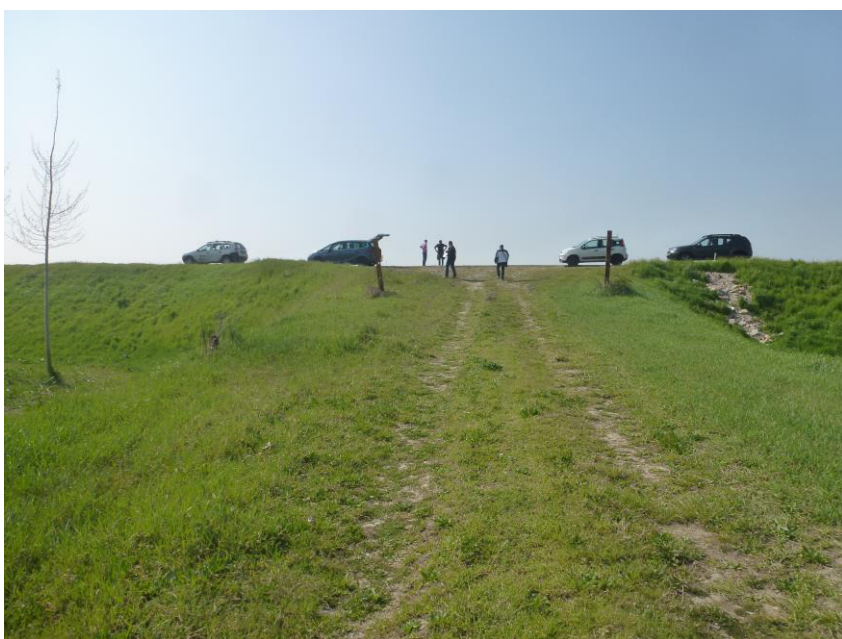
Discesa in golena: la rampa verrà utilizzata durante il cantiere per il trasporto del materiale terroso.
